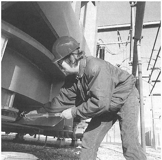
**Bild 3 Isolieröl-Probenentnahme**
