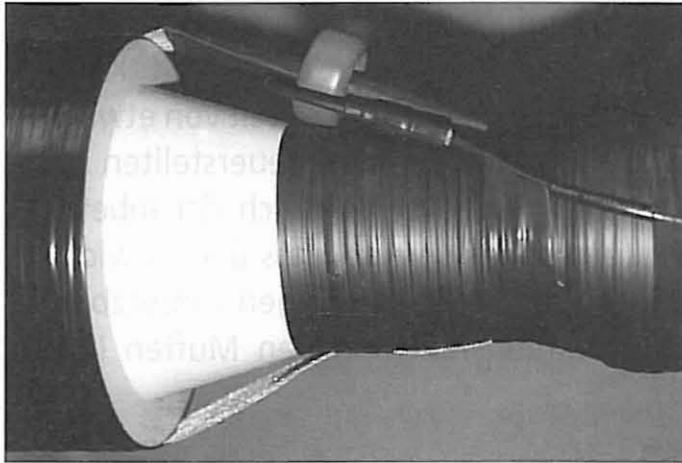
Bild 2 TE-Sensor an Aufschiebemuffe installiert (vorgefertigter Muffenkörper links).
