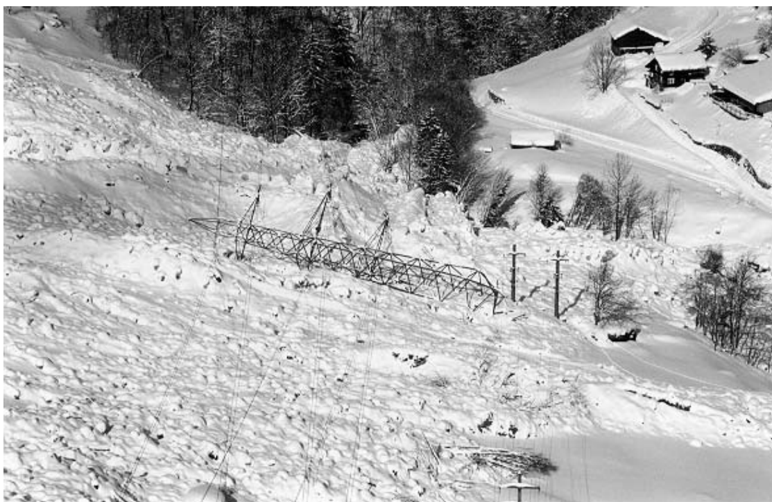
Abb. 3 Zerstörter Strommast in Engi (GL). Foto NOK.
