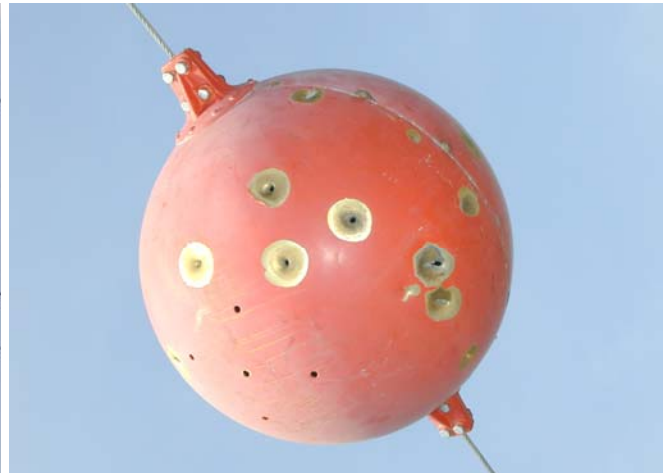
Abb. 2 Einschusslöcher in der Fliegerkugel deuten auf versteckte Seilchwächungen hin.
