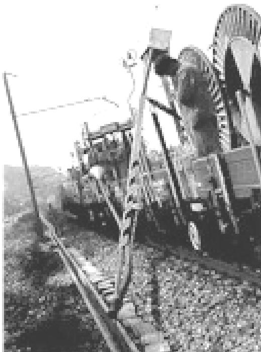
Die Metallfreiheit führt zu leichten Kabeln mit einem spezifischen Kabelgewicht von etwa 300 g/m. Die SBB rollen die Kabel von gleisgebundenen Kabelverlegeeinheiten in den Kabelkanal ab. Die Belastungen auf das LWL-Kabel sind kontrolliert und gering. Das Bruttogewicht (Trommel mit Kabel) ist auf 6.5 t limitiert. Voraussichtlich noch im Jahr 2000 wird die SBB ein 11 km langes LWL-Kabel durch den Simplontunnel abrollen. Das Kabel allein wiegt nur zirka 3.3 t.
