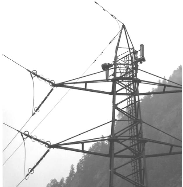
**Abbildung 2** GSM- und Richtstrahlantennen auf einem Freileitungsmast.
