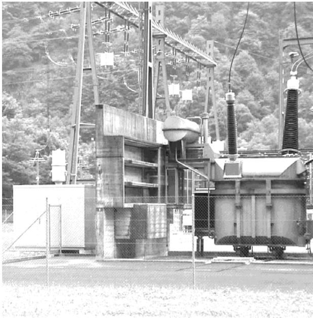
**Abbildung 1** Container mit SDH-Knoten und GSM-Basisstation in einer Hochspannungsfreiluftschaltanlage.
