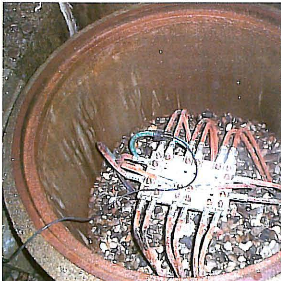
Bild 10: Messung von Erdleiterströmen in der Schienenstromrückführung mit kleinem Rogowski-Stromwandler.
