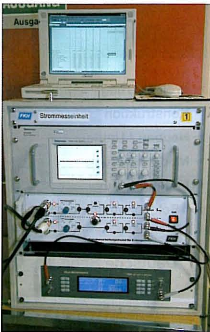
Bild 12: Messeinrichtung zur Erfassung von Schleifenimpedanzen, Erdleiterströmen und Differenzspannungen.
