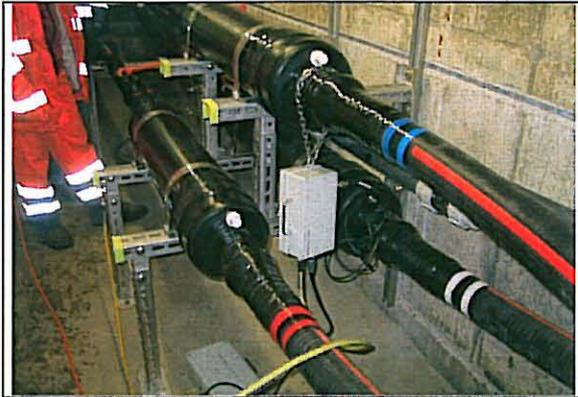
**Bild 9** Verstärker und Messkabel im Muffenschacht
