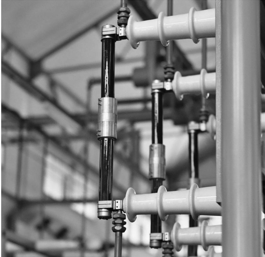
**Photo 3** Fusibles HT en montage ad-hoc destinés à protéger des TP 65 kV contre le court-circuit et l'explosion
