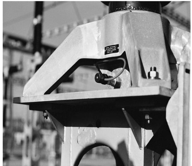
**Photo 4** Pressostat de déclenchement pour TI
