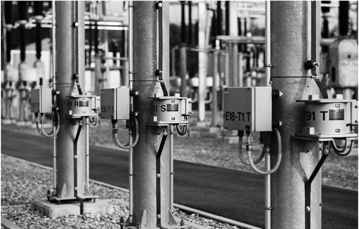
**Photo 5** Champ 125 kV de transformateur 200 MVA, appareillage avec TI de protection "masse cuve étendue"
