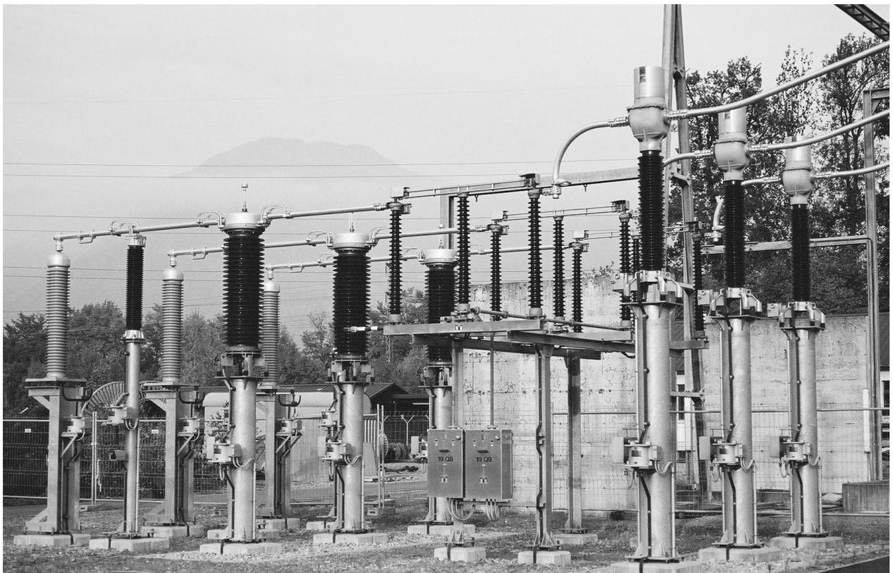
**Photo 6** Champ 125 kV de transformateur 60 MVA avec TI de protect. masse cuve étendue et coffrets de dispositifs parasurtension Leutron-EOS
