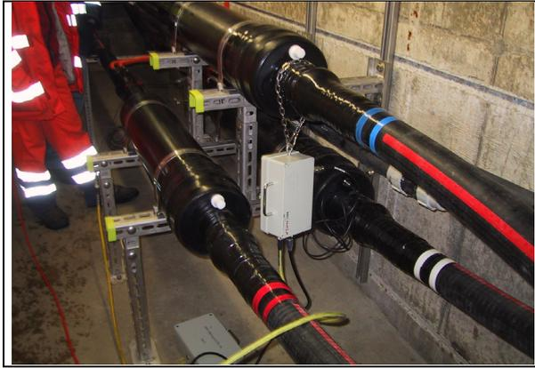
**Bild 9** Verstärker und Messkabel im Muffenschacht
