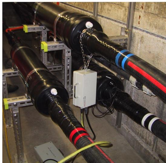
Abbildung 15: TE-Messung an einer Crossbondingmuffe mit eingebautem TE-Sensor
