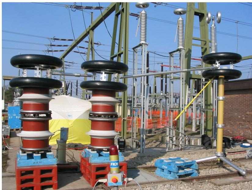
Abbildung 1: Modulare Serie-Resonanzanlage (Einspeisung in die GIS über ein Trafokabel)
