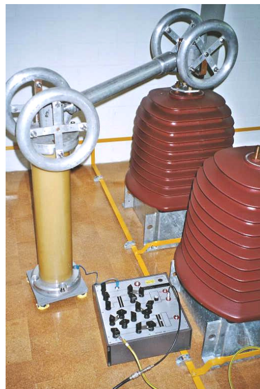
Abbildung 21 TE-Auskopplung an einem externen Koppelkondensator
