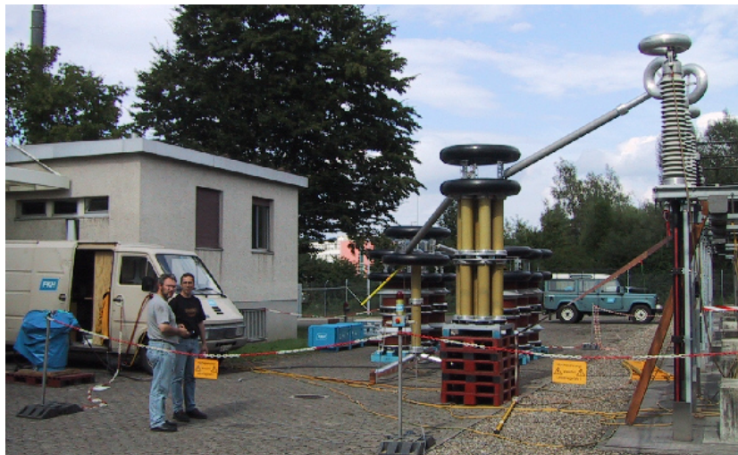
Abbildung 12: Prüfanlage mit Koppelkondensator, Freiluftendverschluss
