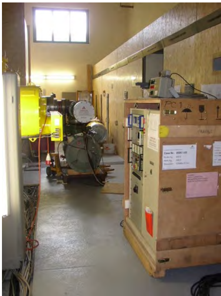
Abbildung 15: sorgfältige Prüfung - 50 Hz, 1 min. und TE-Messung bei 120 kV
