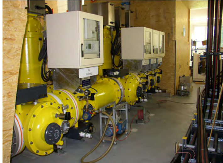
Abbildung 12: Prov. Teilbetrieb mit 4 Feldern, Trennwände zur Sicherung
