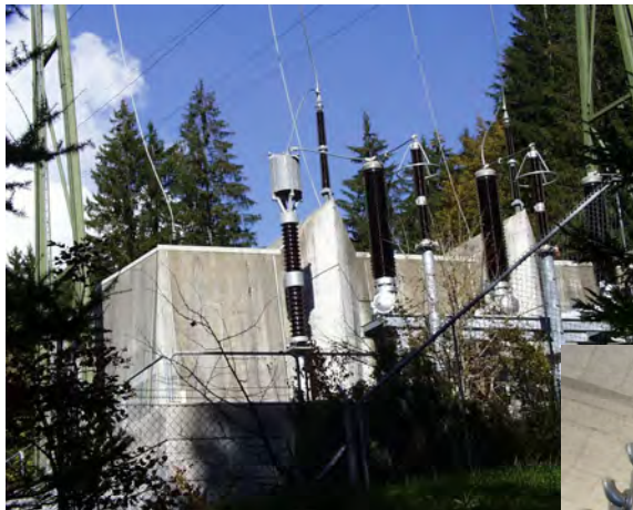
gekapselte Einführung in die 220-kV-GIS
