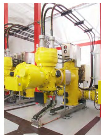
Abbildung 10: Steckkabel und KEV nach oben, (KEV 180° drehbar, Anschluss unten möglich)
