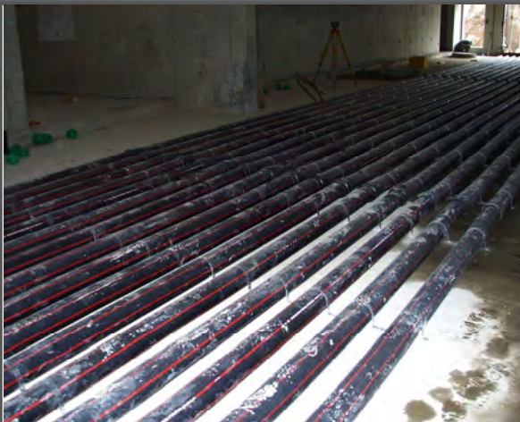
Tube pour câbles 130 kV avant bétonnage
