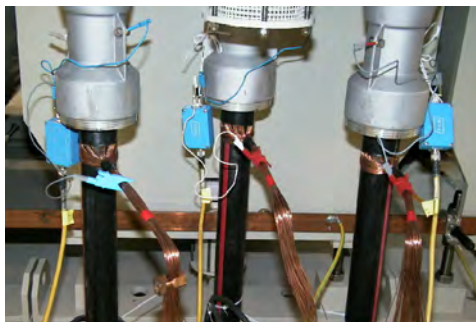
Abbildung 10 a) TE-Ankopplung an den Steck-Kabelendverschlüssen der GIS (Messstelle 2) b) TE-Ankopplung am Transformatorsternpunkt (Messstelle 4) c) Teilentladungsmesssystem
