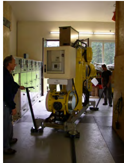
Abbildung 14: Rollensystem für Felderplatzierung
