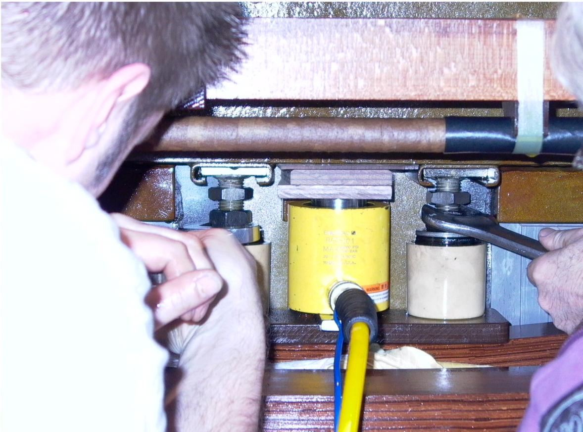
**Abbildung 4** Austausch schadhafter Isolierteile der Presskonstruktion und Nachpressung eines 300/3-MVA-Maschinentransformators 380/13 kV
