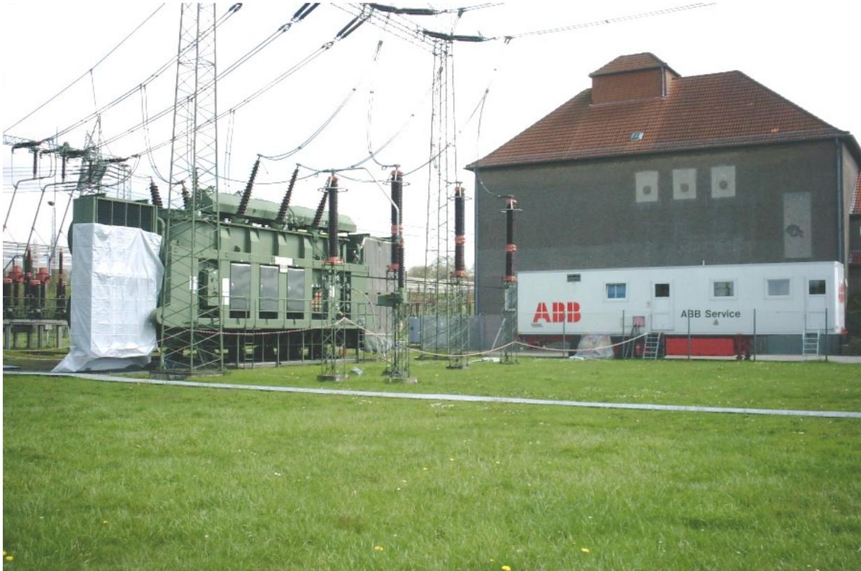
**Abbildung 4: Moderne Ölregenerieranlage mit integrierter Wiederaufbereitung der Fullererde**
