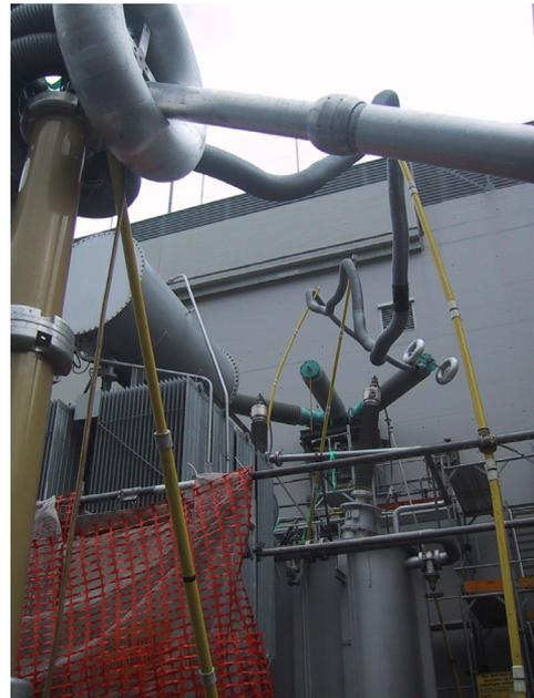
Abbildung 10: Anschluss an GIS-Anlage durch Trafazelle
