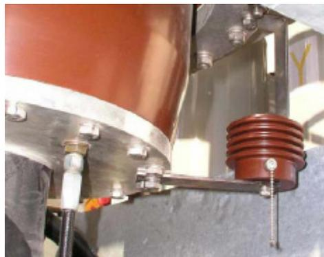
Bild 1: Induktiver TE-Sensor, montiert an einem GIS-Kabelendverschluss
