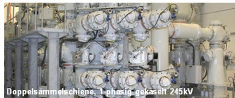
Doppelsammelschiene, 1-phasig gekapselt 245kV
