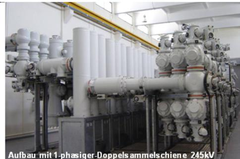
Aufbau mit 1-phasiger Doppelsammelschiene 245kV
