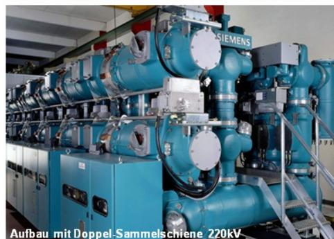
Aufbau mit Doppel-Sammelschiene 220kV
