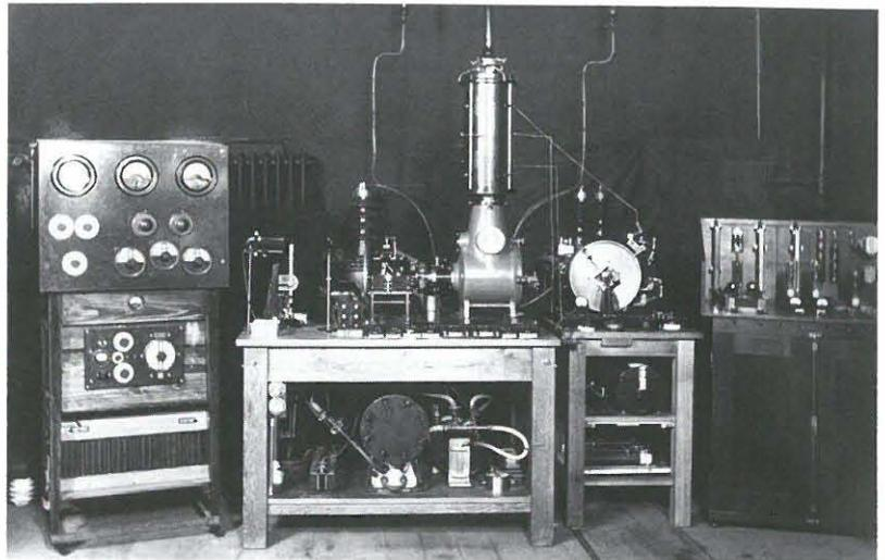
**Bild 1:** Erster funktionsfähiger Kalkathodenstrahl-Oszillograph der schweizerischen Kathodenstrahl-Oszillographen-Kommission im Jahr 1926 (alle Fotos: Sammlung FKH).
