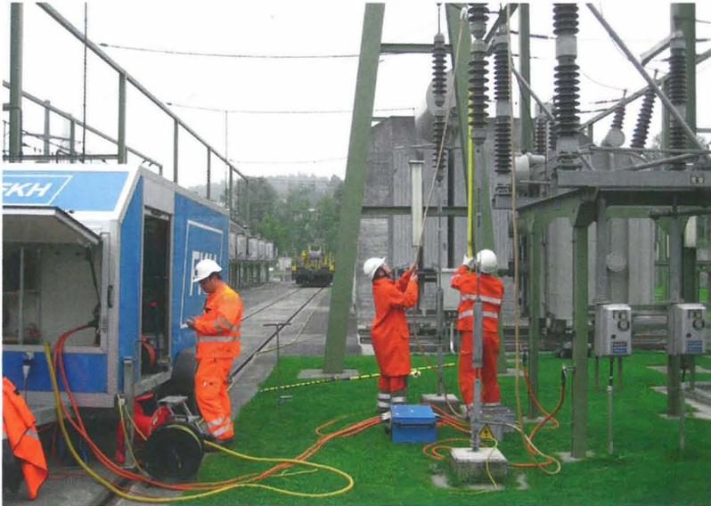
**Bild 7:** Erdungsmessungen an Fernleitungsabzweig in SBB-Unterwerk mit straßenfahbarem Messanhänger der FKH mit 50-kVA-Umrichter, Kompensationseinheit und Messeinrichtungen (Bild 8).
