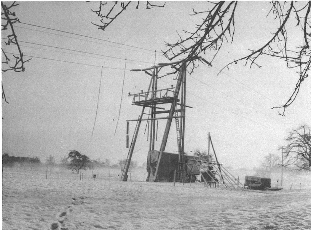
Bild 33. 150 kV-Leitung; Abspannmast mit geöffneter Leitung und Schaltbühne, Stoßwagen und Drosselspule.
