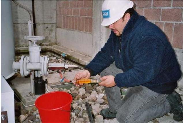
Abbildung 16 Vorschriftsmässige Probenentnahme an einem Transformator für die spätere Zersetzungsgasanalyse
