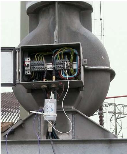
Abbildung 10 Erfassung des Stroms durch die Primärwicklung des Spannungswandlers
