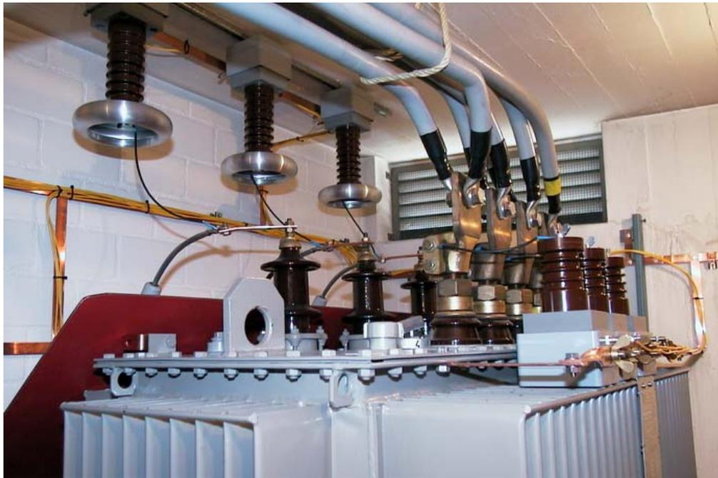
Abbildung 6 Montage der Spannungsteiler auf der 400-V-Unterspannungsseite (vorne rechts) und der 22/11-kV-Oberspannungsseite (hinten links)
