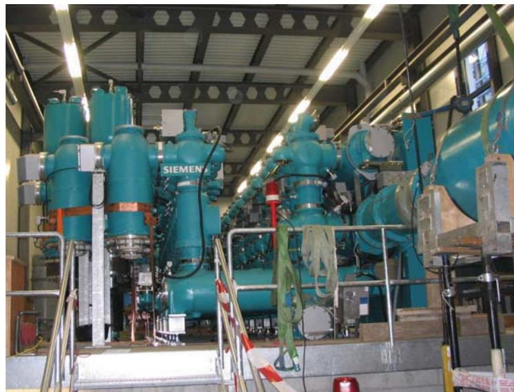
Bild 6 245-kV-GIS in der UST Handeck. Rechts die angeflanschte Resonanzdrossel für die GIS-Prüfung
