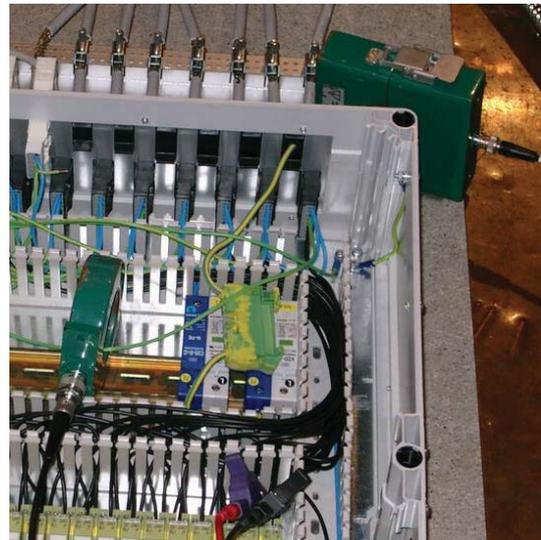
**Bild 7** Messung einer allfälligen Beeinträchtigung der Storensteuerung durch Überspannungen und -ströme
