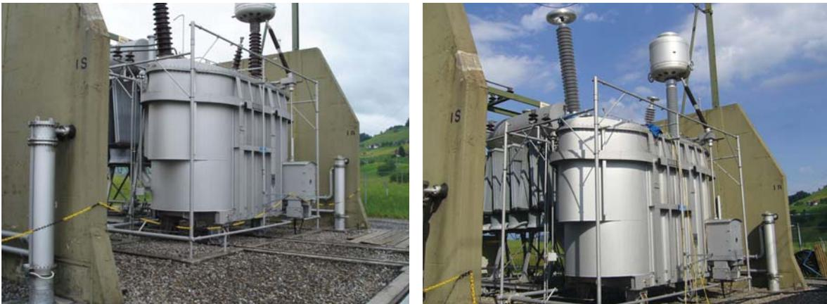
**Bild 4:** 220-kV-Transformator vor und nach dem Austauschen der Durchführungen
