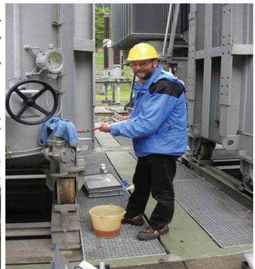
Bild 16 ... und am Bodenablassventil eines Transformators
