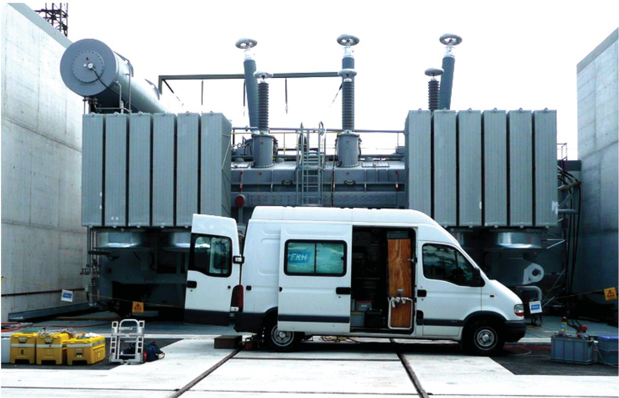
Bild 25 220-kV/150-kV-250-MVA-Phasenschieber-Transformator bei der Prüfung im ewz-Unterwerk Fällanden
