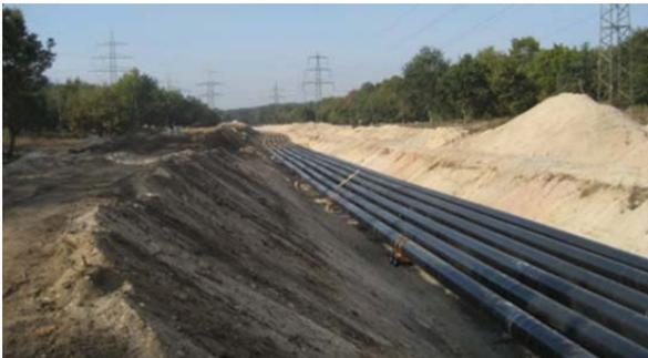
Bild 4 GIL-Rohre in Kelsterbach, noch nicht zugedeckt (Bild Siemens)
