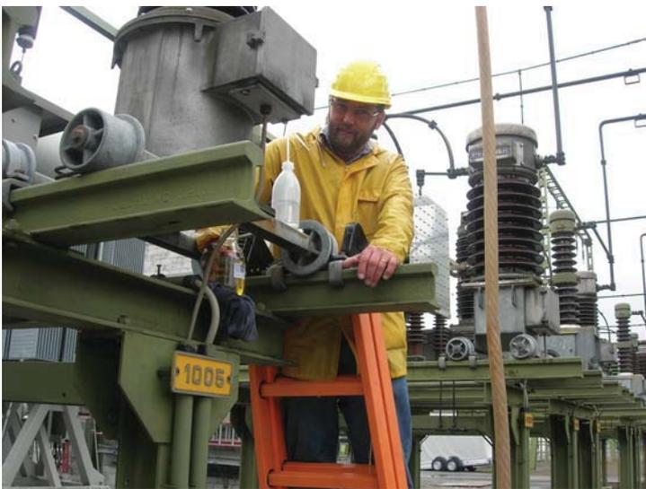
Bild 15 Der stellvertretende Laborleiter Matthias Weidmann bei einer Isolieröl-Probenahme auf dem Gerüst einer Messgruppe
