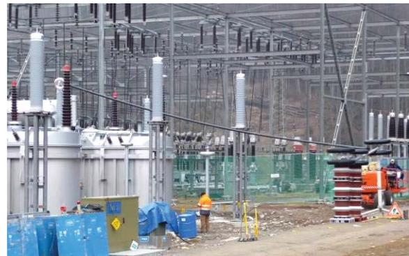
Bild 26: Prüfung im 380-kV-Unterwerk Lavorgo, Länge der Verbindungsstange 12 m
