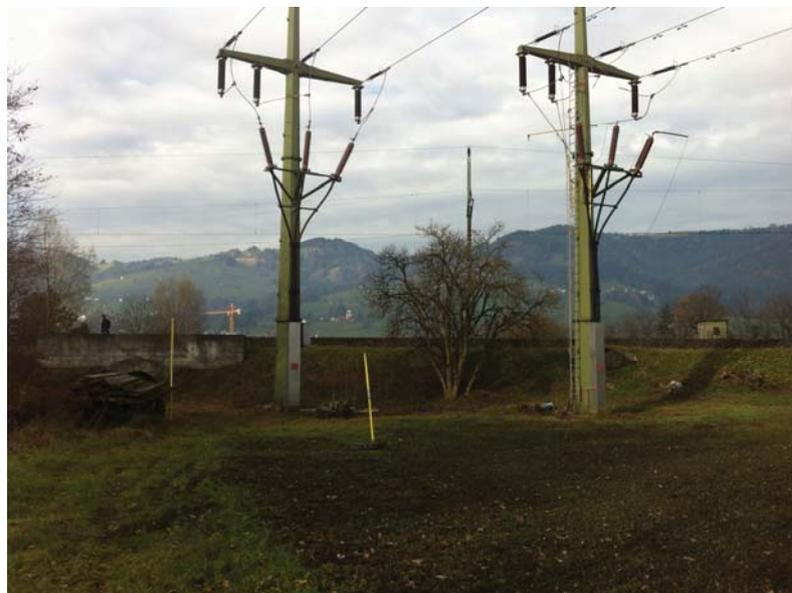
Bild 23: Isolierstützen zur Spannungszuführung für die Kabelprüfung am linken Endmast
