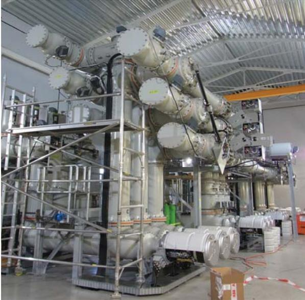
Bild 11: ELK-3 GIS, an der noch letzte Installationsarbeiten durchgeführt werden
