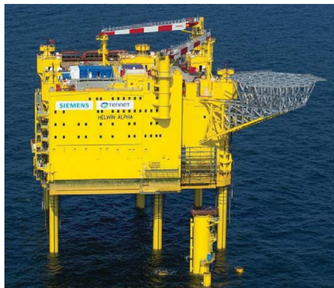
Abbildung 4: Ansicht einer Plattform in der Nordsee 1
