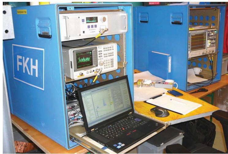
Abbildung 2: UHF-TE-Messaufbau für Schmalbandmessung (empfindlichste UHF-TE-Methode) sowie elektrische Laufzeitmessung mit einem 2 GHz / 4 Kanal Oszilloskop zur Ortung der Teilentladungen
