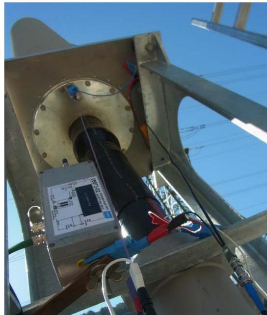
**Bild 7** Kabelendverschluss mit Ankoppelvierpol zwischen Kabelschirm und Erdung.
