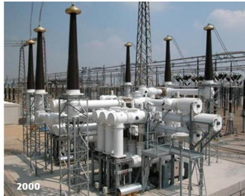
420kV / 550kV GIS Leistungsschalter- P 7
