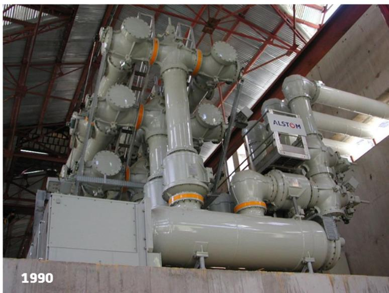
420kV / 550kV GIS Leistungsschalter- P 4
