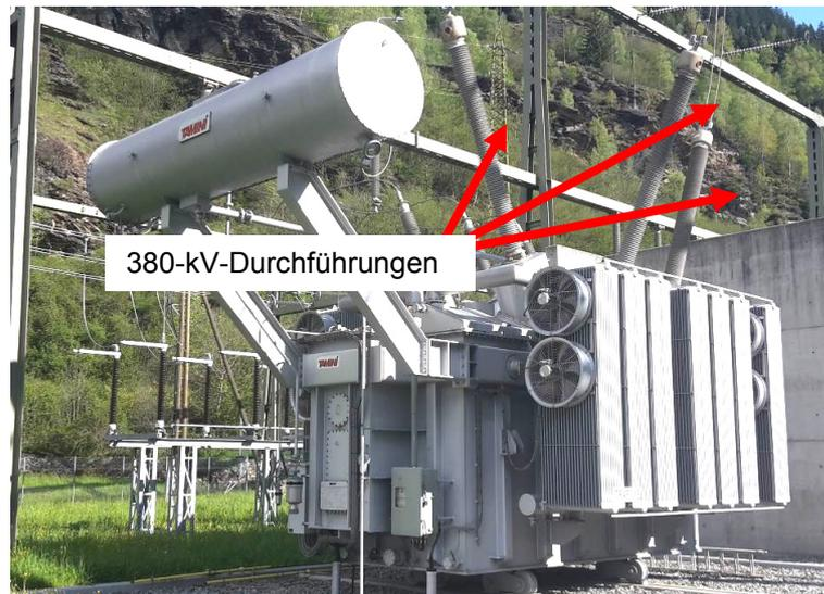
Abbildung 1 380/150-kV-Transformator 1B im UW Robbia
