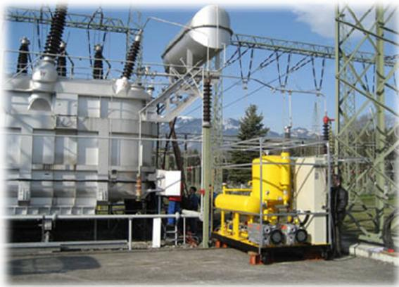
Abbildung 2 Micafluid Ölaufbereitungsanlage im „Onload“ Einsatz bei VKW Bregenz AT
