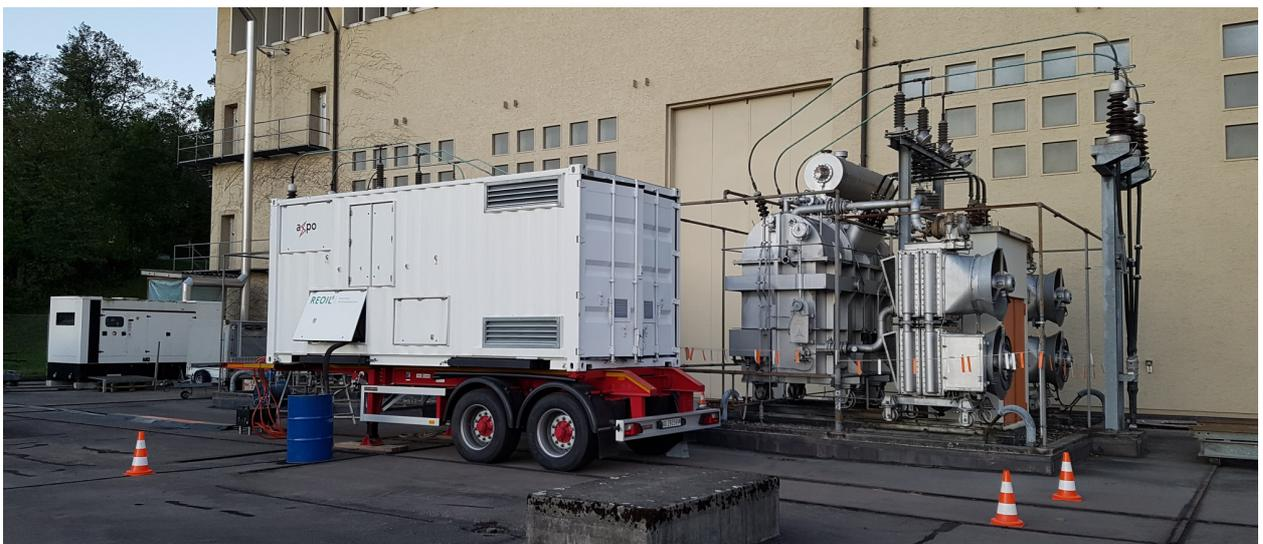
**Abbildung 3** Reoilanlage 5000-9: Einsatz an einem 30 MVA Maschinentrafo mit Jahrgang 1969
