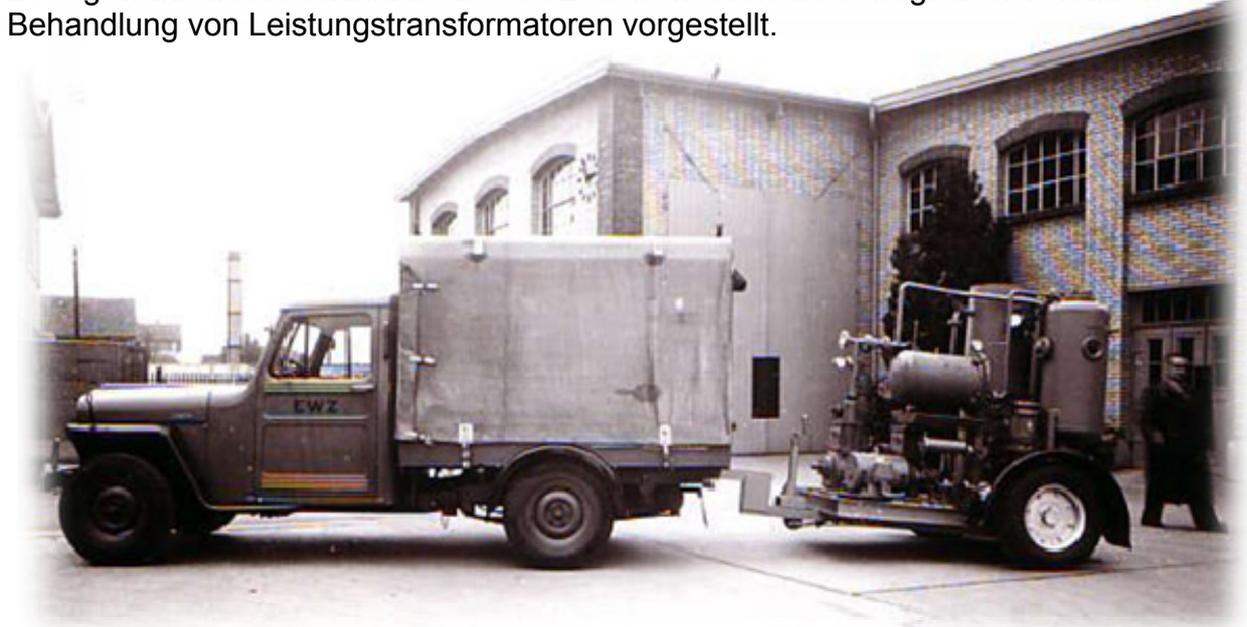
Abbildung 1 Erste mobile Ölaufbereitungsanlage von Micafluid AG, Schweiz geliefert 1929 an die EWZ
