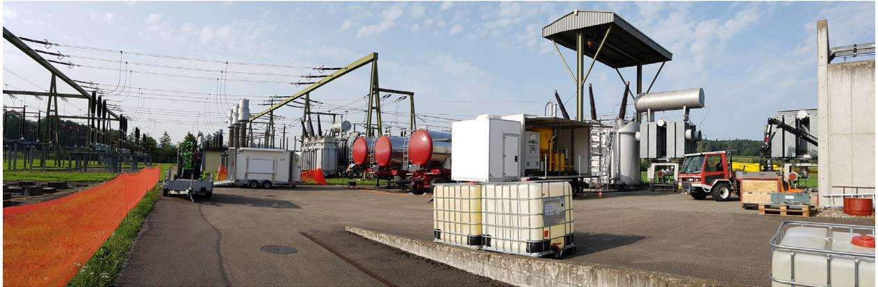
**Abbildung 2** Ölaufbereitung auf der Anlage mit VOP 90 RS, Vakuumfesten, isolierten Tanks nach Verschiebung eines 125 MVA Trafos
