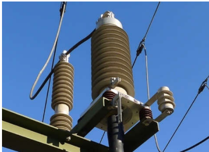
Abbildung 14: Erdungsgarnitur mit SVL und Trennmesser an einem Freiluftendverschluss (UW Vorziers)
