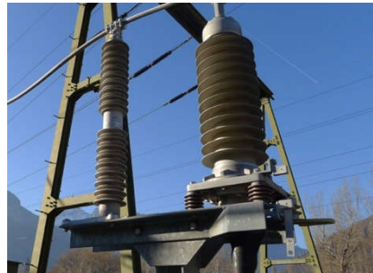
Abbildung 14: Erdungsgarnitur mit SVL und Trennmesser an einem Freiluftendverschluss (UW Vorziers)
