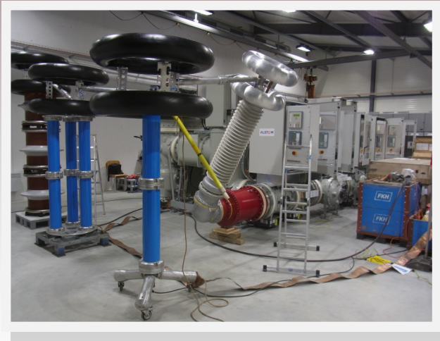
Installation d'essai d'un PSEM 123 kV
