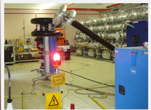
Test de tension avec mesure UHF d'un PSEM de 123 kV
