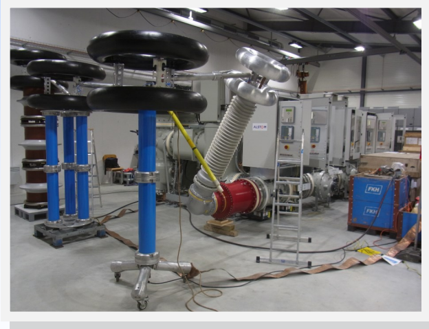
GIS-Prüfungsaufbau an einer 123-kV-Anlage
