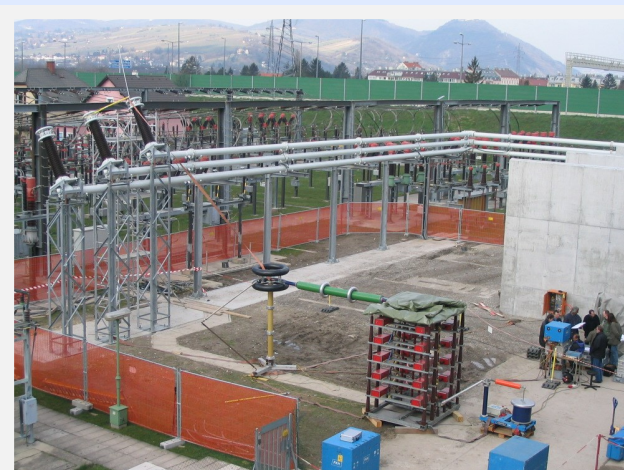
Prüfung an einer 123-kV-GIS mit schwingendem Blitzstoss
