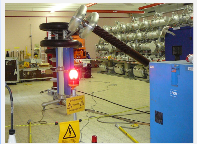
Spannungsprüfung mit UHF-TE-Messung einer 123-kV-GIS
