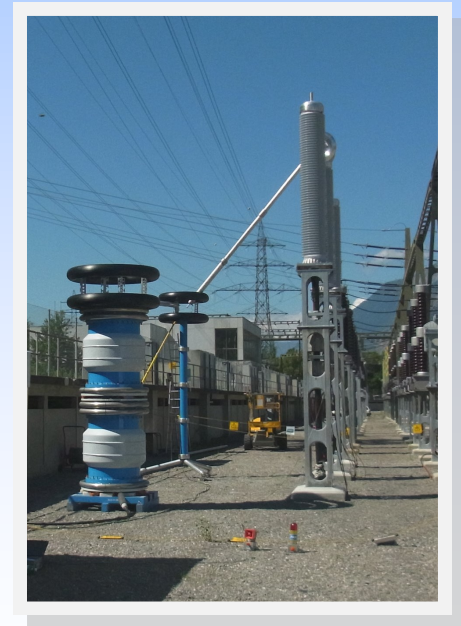
Hochspannungsresonanzprüfung an einer 275-kV-Kabelverbindung
