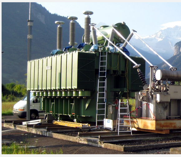
Excitation d'un transformateur pour des mesures de décharges partielles dans une sous-station.
