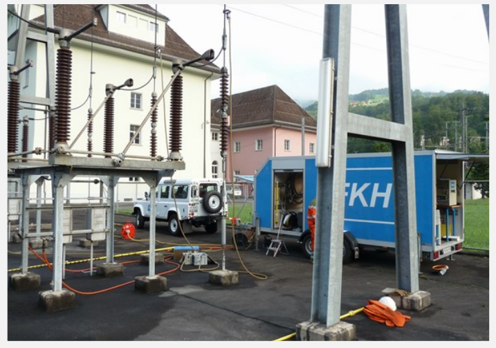
Mesures de terre : alimentation d'une ligne haute tension de transmissions avec un courant de test dans une sous-station.
