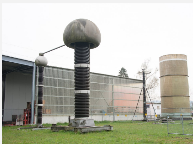
Transformateur d'essai 1000 kV à Däniken, centre d'essai
