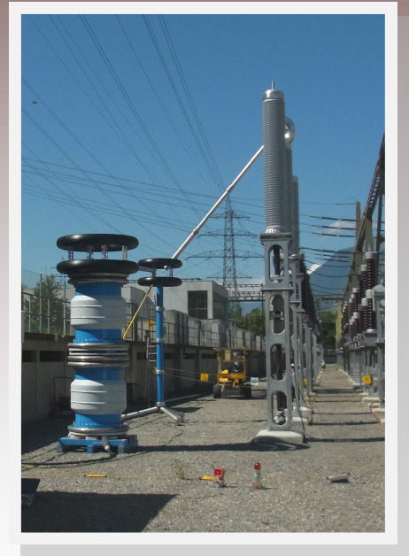
Essai haute tension d'une liaison câblée de 275 kV
