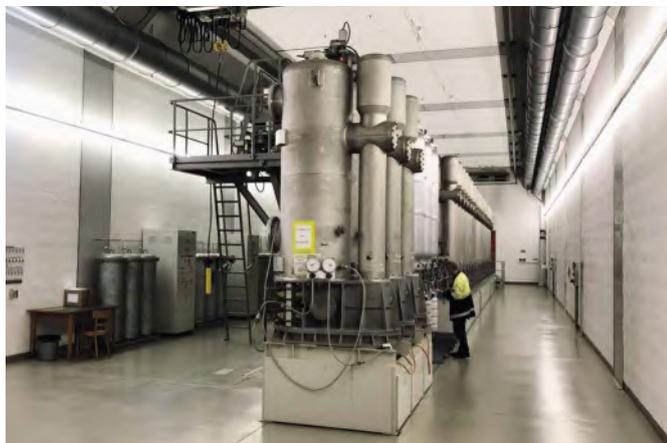
Abbildung 1: Unterwerk Katz, 150 kV-GIS von BBC, Typ ELK BC aus dem Jahr 1977
