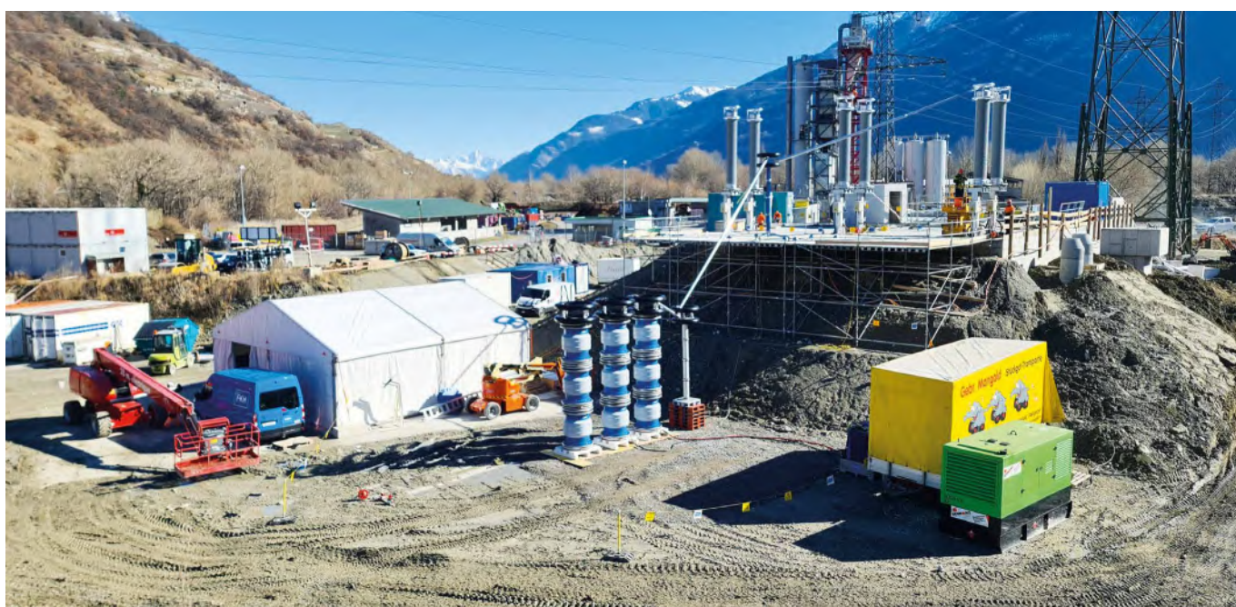
Abbildung 1: Serienresonanzanlage für die Prüfung des Kabelsystems Romanel
