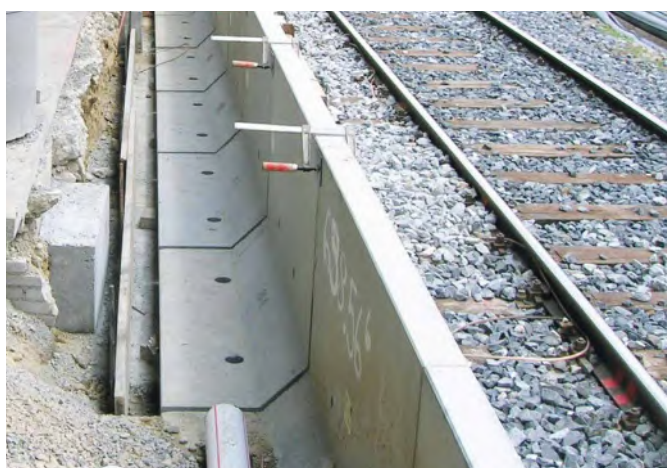
Abbildung 1: Einbau von Betonwinkel-Fertigelementen an einer Bahnsteigkante (Foto mit freundlicher Genehmigung der WBI, AG, Schaffhausen, www.wbi.ch )
