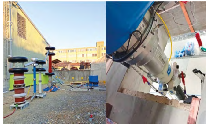
Abbildung 4: Kabelprüfadapter für die Prüfung der 145-kV-GIS Therwil (Einspeisung via Vorplatz durch vorhandene Kabelrohre via Kabelkeller auf die GIS; GIS mit synthetischer Luft als Isoliergas)
