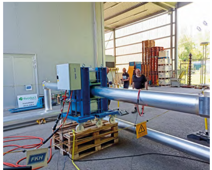
Abbildung 3: Hivoduct-Prüfpol und Erwärmungsprüfungsaufbau
