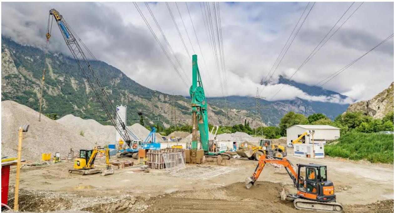
Abbildung 6: Bauarbeiten für die Startgrube des Mikrotunnels Le Verney - La Batiatz, Quelle: <https://www.swissgrid.ch/de/home/projects/project-overview/nant-de-drance.html>
