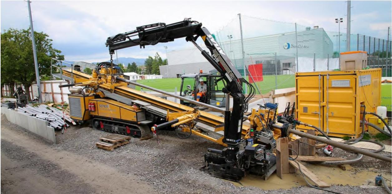
**Abbildung 7: Bohrmachine und Flüssigkeitsaufbereitungsanlage, Quelle:**
