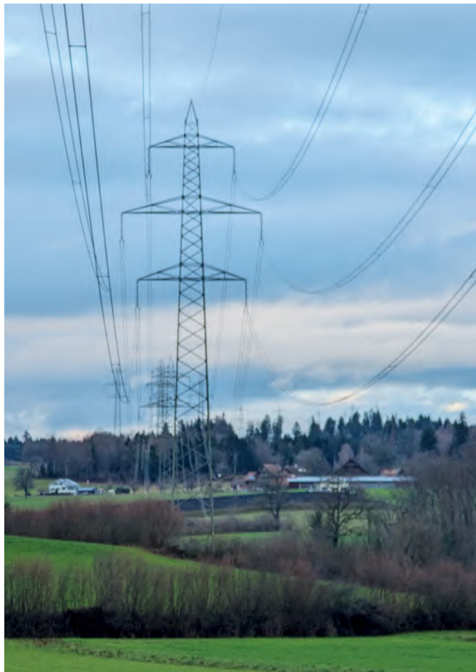
Abbildung 1: 380/220-kV-Freileitung mit 600-mm 2 -Zweierleiterbündeln, im Hintergrund Gebäude für die Überprüfung der Einhaltung der Lärmschutzverordnung
