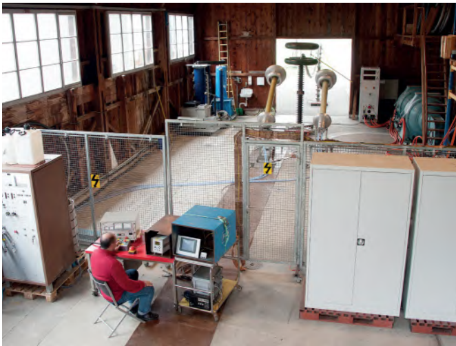
Abbildung 1: Bestehender, nicht mehr zeitgemässer Prüfplatz
