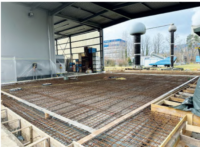
Abbildung 6: Neubau Bodenplatte für überdachten Vorplatz
