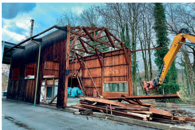
Abbildung 3: Abbruch bestehendes Gebäude (Koronaschopf)
