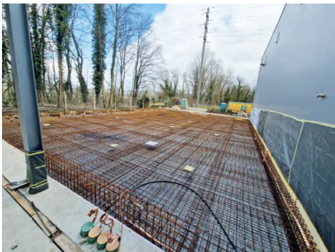
Abbildung 4: Neubau Bodenplatte Mehrzweckhalle
