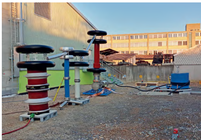
Abbildung 2: Prüfanlage zur Prüfung der 145-kV-GIS
