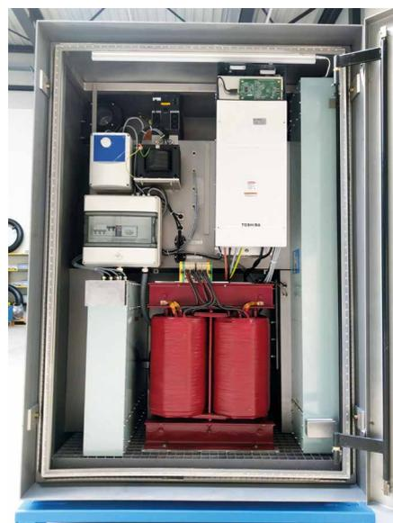
Abbildung 2: offener Umrichterschrank, in der Mitte oben: Frequenzumrichter, unten: Trenntrafo, links: Eingangsfilter, rechts: Ausgangsfilter
