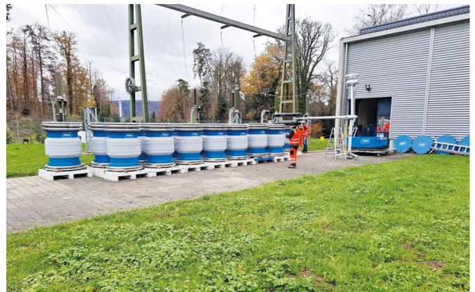
Abbildung 2: Drosselbatterie mit 17 Stück 80-H-Drosseln für ein 132-kV-Kabel
