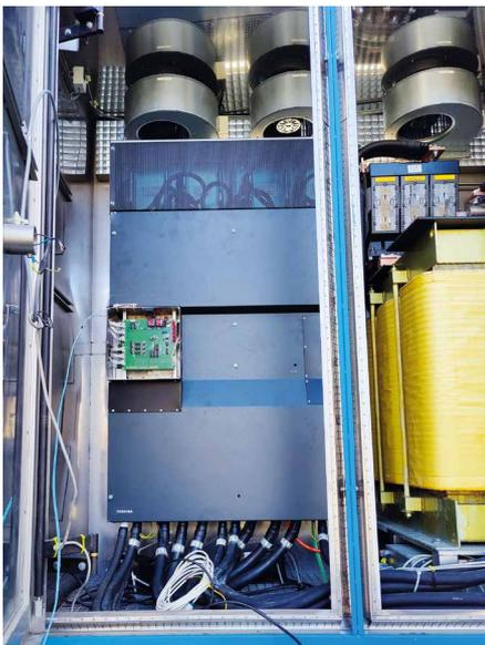
Abbildung 3: 950-A-Umrichter mit Steuerung von Alff Engineering (grüne Leiterplatte) in der Prüfquelle für Transformatoren
