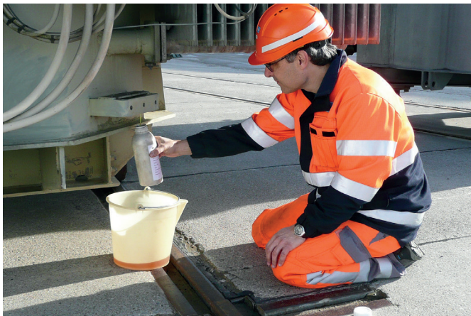
Abbildung 20: Ölprobenahme an einem Transformator
