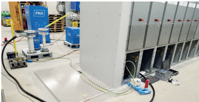
Abbildung 9: Prüfung einer Mittelspannungsschaltanlage
