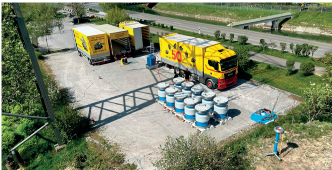
Abbildung 5: Serieresonanzanlage für eine Kabelprüfung ohne Teilentladungsmessung
