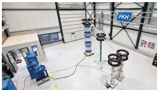
Illustration 2: Installation de résonance série dans le grand laboratoire d'essais
