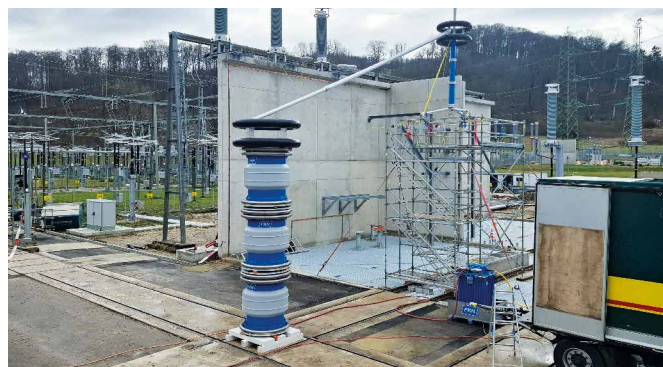
Illustration 6: Installation d'essai par résonance pour un système de câbles de 220 kV avec mesure des décharges partielles
